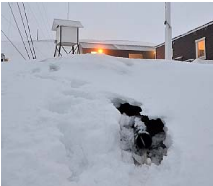
Det nyeste avløpet ved Hopen Meteo. Hvor tror du neste røropplegg kommer?
