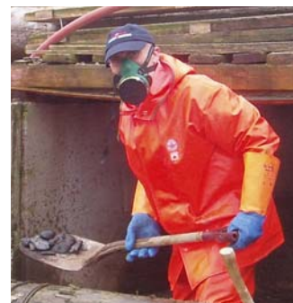
Sikkerheten først. Rolf Arne Larsen iført korrekt verneutstyr for fjerning av septikk.
