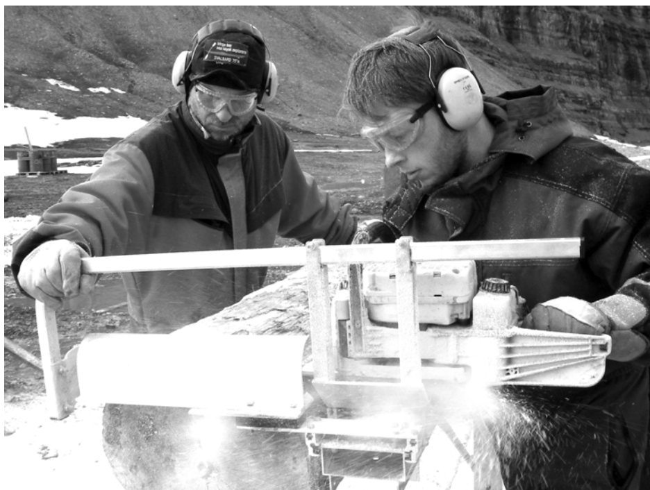
Full gass i fjæra: Arkitekt og byggmester Roar Kihle, her assistert av Ole Aksel Torp, sager byggematerialer av fisefineste kvalitet.
